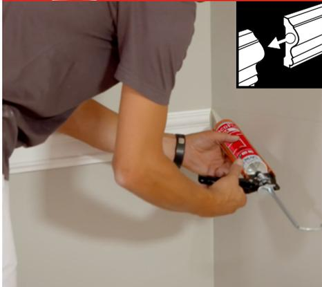
**Use DecoFix Ultra in every joint** | Gebruik DecoFix Ultra in elke naad | Utilisez DecoFix Ultra pour chaque joint | Verwenden Sie DecoFix Ultra bei jeder Naht | Aplica DecoFix Ultra en todas las juntas | Utilizzare DecoFix Ultra in ogni giunta | Użyj DecoFix Ultra w każdym złączu
