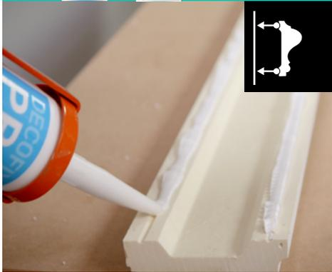
**Apply adhesive over the entire gluing surface** | Breng lijm aan over het volledig lijmoppervlak | Appliquez la colle sur toute la surface dédiée | Tragen Sie Kleber auf der gesamten Klebefläche auf | Aplica adhesivo sobre toda la superficie de adhesión | Applicare l'adesivo sull'intera lunghezza | Nalóż klej na całej długości
